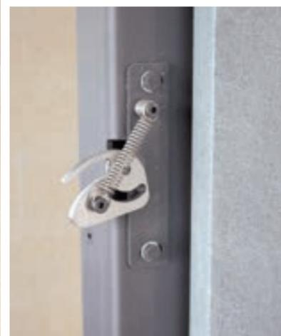
Alle Bedien- und Verschlusssteile, in Edelstahl und Holz, werden bewusst gezeigt.
